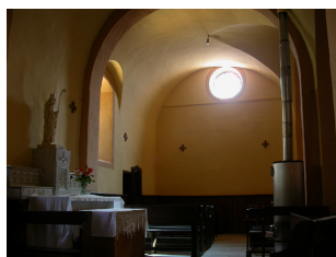
Collatéral. Vue de volume prise d'ouest en est.
