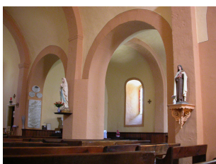
Nef. Deuxième et troisième travées, vues du sud-est.
