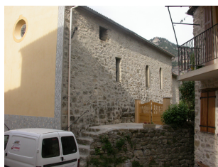
Elévation nord. Vue d'ensemble prise du nord-est.
