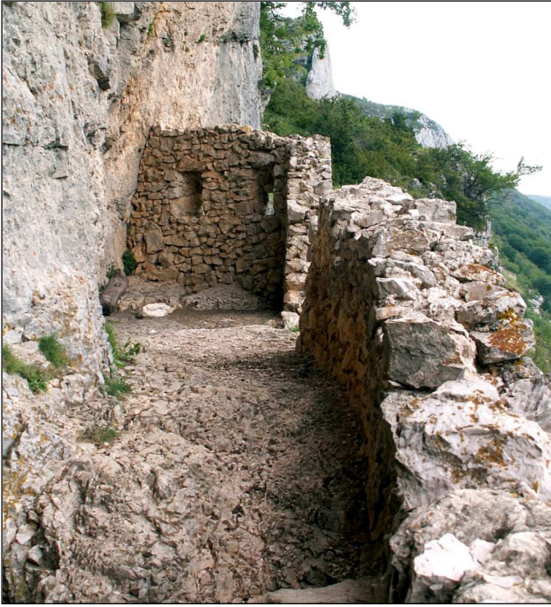
Fig. 4 : Le mur de défense du premier étage et les deux meurtrières encore en place.
