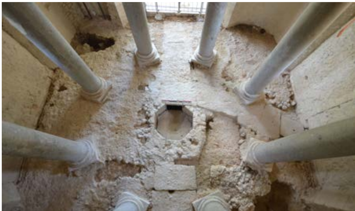
Vue zénithale du sol et de la cuve du baptistère de Riez
