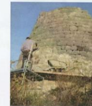
Réparation de la tour 2020
