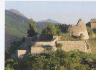
Travaux de renforcement 2017-2021
