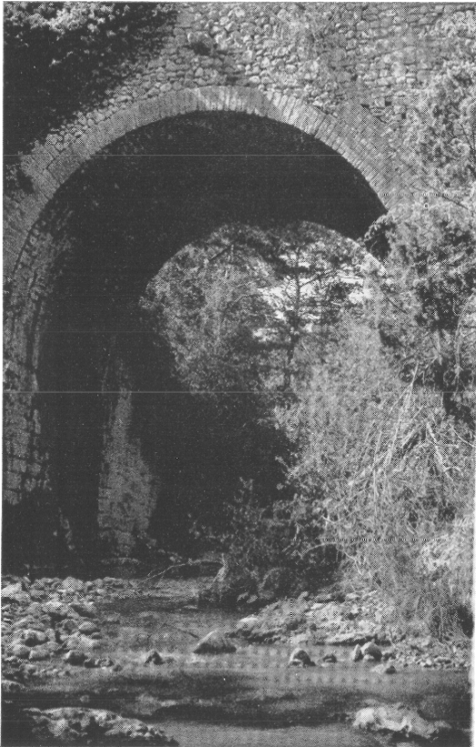
Fig. 4. — Le pont romain de Ganagobie : vue générale de la face est.
