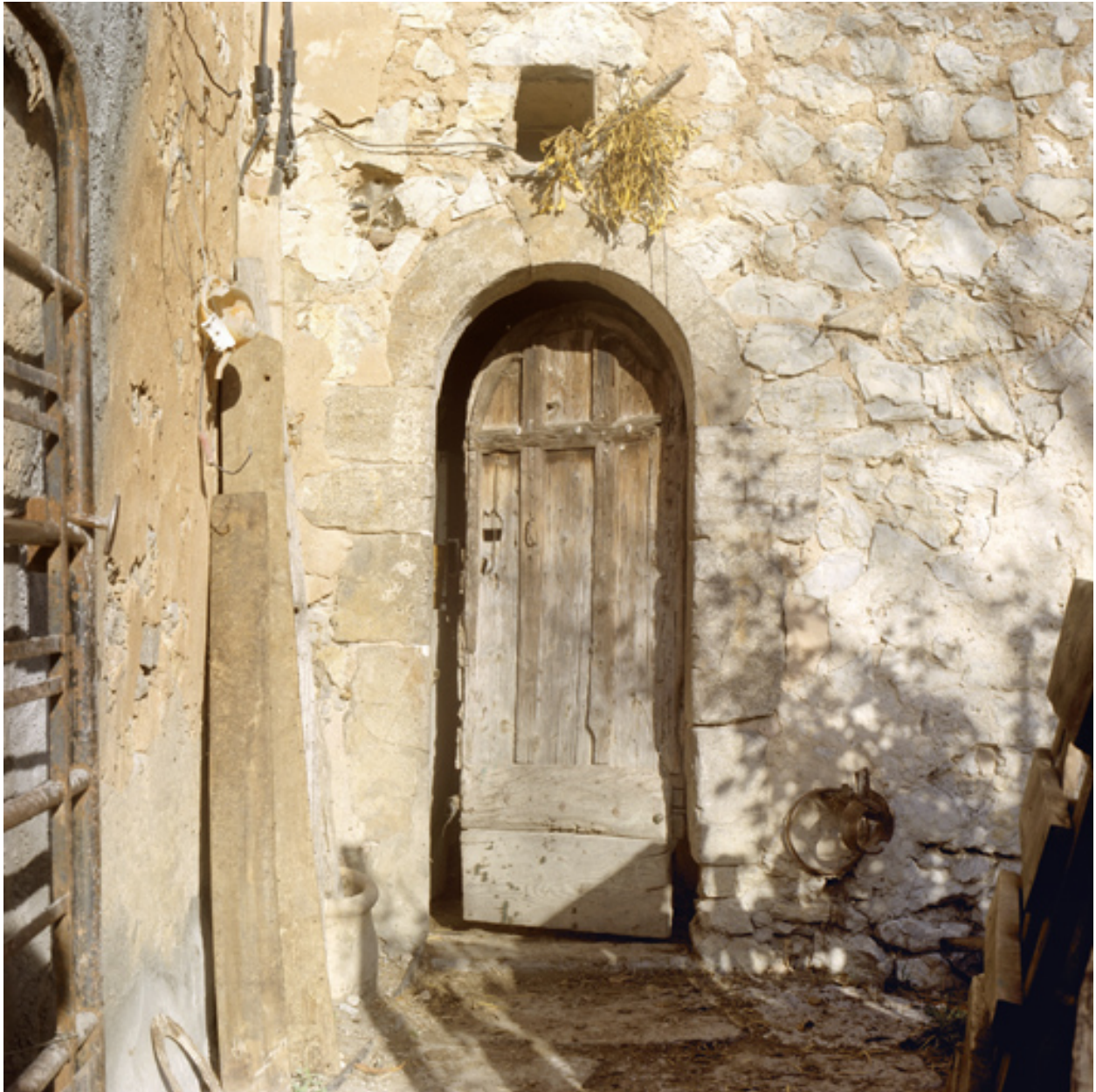
Détail de la façade ouest : porte.
