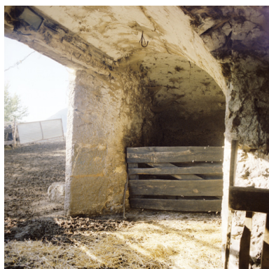
Vue intérieure de la bergerie. Phot. Françoise Baussan IVR93_20060402391XE
