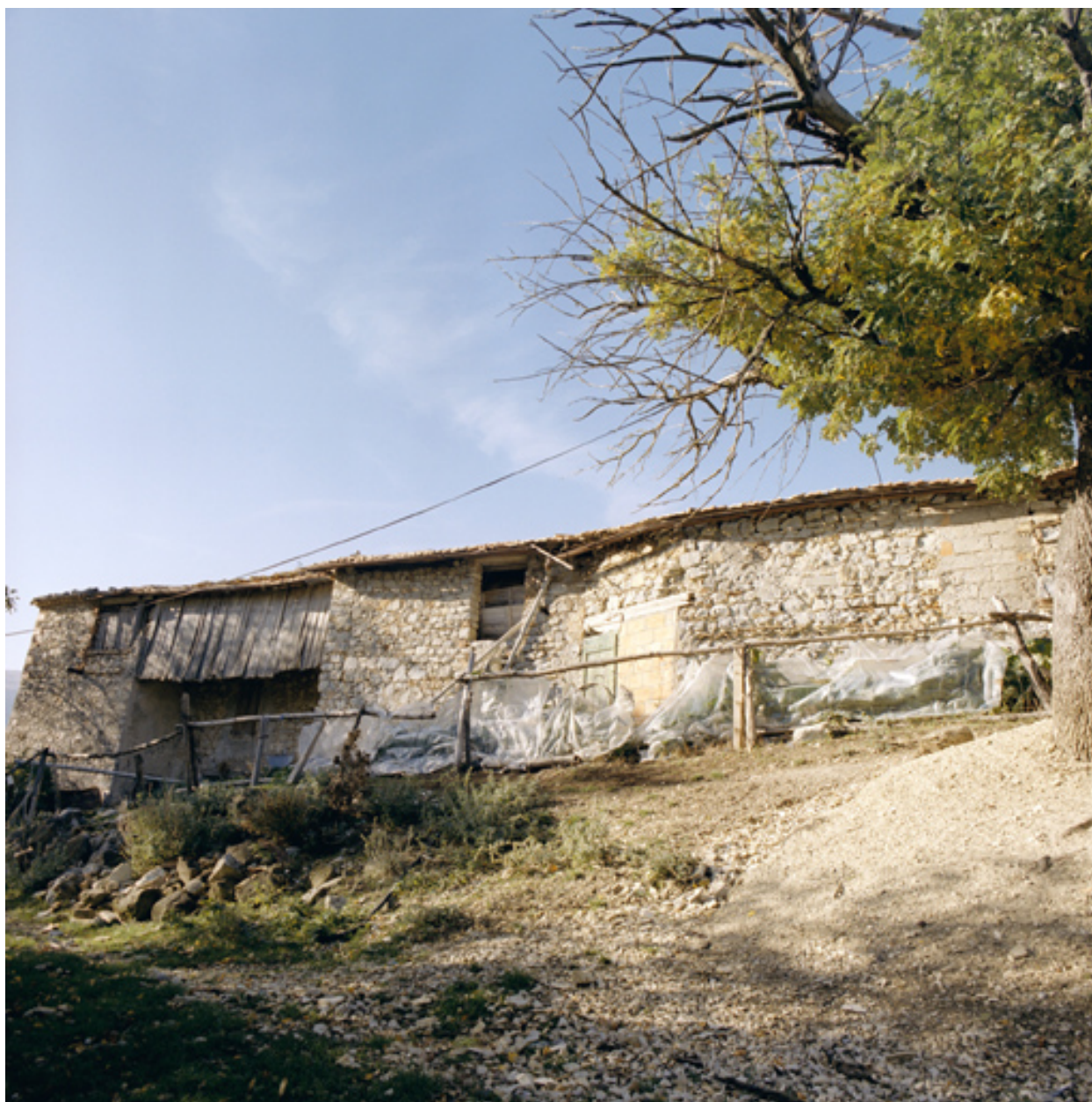
Vue générale de la façade postérieure depuis l'est.
