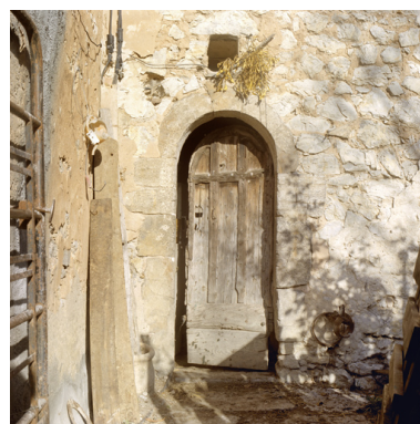
Détail de la façade ouest : porte. Phot. Françoise Baussan IVR93_20060402399XE
