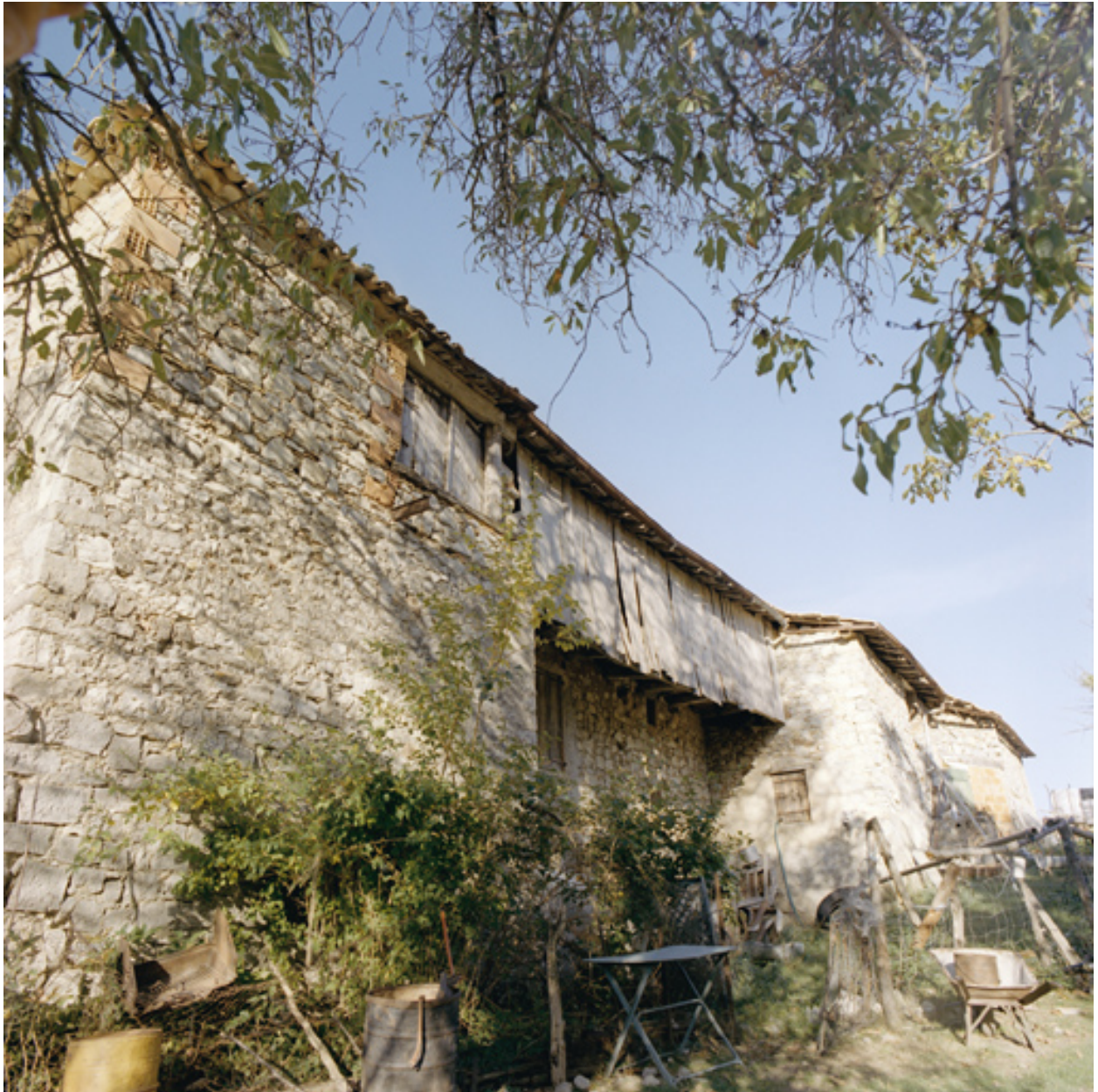
Vue générale de la façade postérieure depuis le sud-est.
