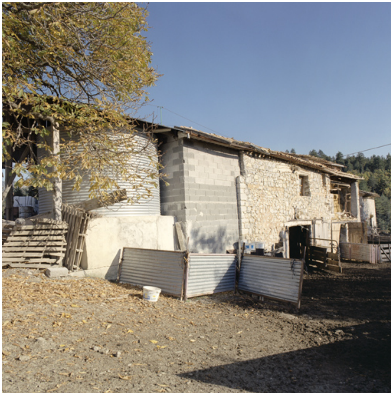
Vue générale des bâtiments agricoles depuis le nord-ouest.
