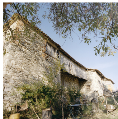
Vue générale de la façade postérieure depuis le sud-est. Phot. Françoise Baussan IVR93_20060402389XE
