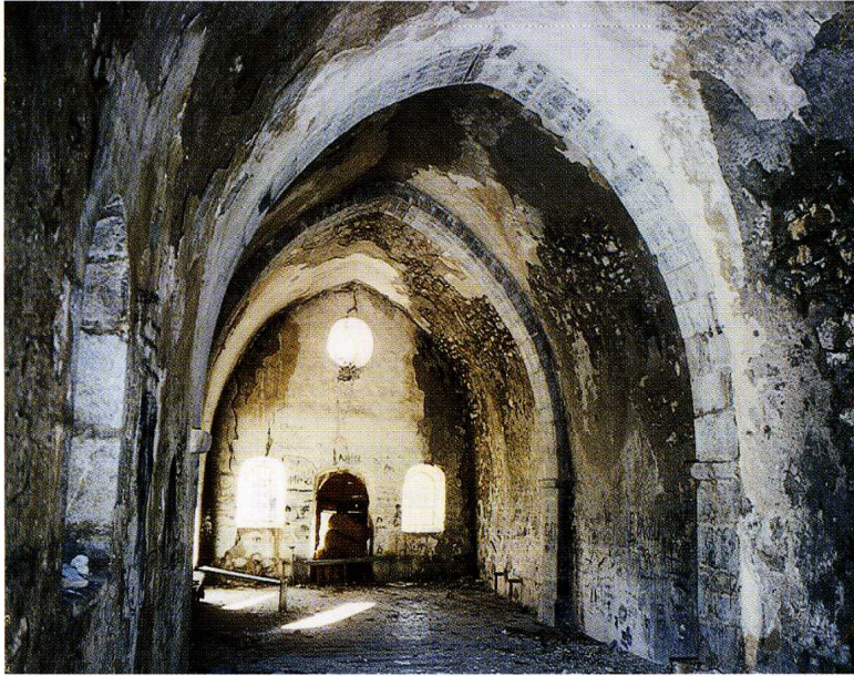
Noyers-sur-Jabron (Alpes-de-Haute-Provence) Chapelle Saint-Claude 2. Vue intérieure prise du chœur vers l'entrée
