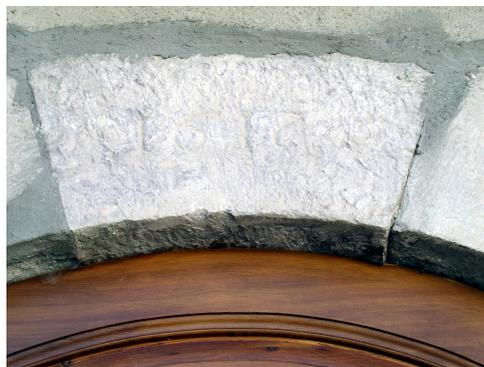
La porte nord était obturée. Des travaux récents l'ont réhabilitée. Son encadrement est formé d'un arc plein cintre constitué de claveaux reposant en continuité sur les piédroits. Claveaux et piédroits sont formés de moellons dont les queues ne sont pas rectilignes au parement de la maçonnerie. L'encadrement est au droit du nu du mur. Sur la clef est gravée la date de 1617
