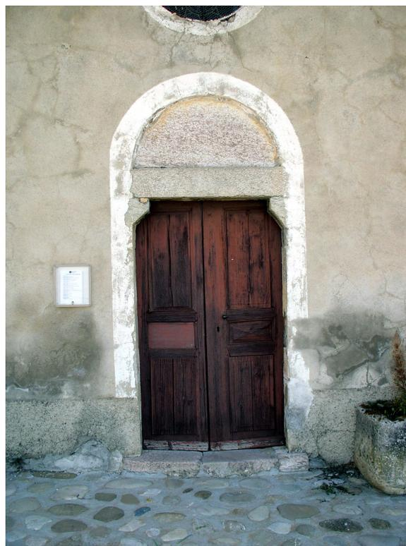
La porte ouest est formée d'un linteau reposant sur deux coussinets. Le linteau est surmonté d'un arc plein cintre.
