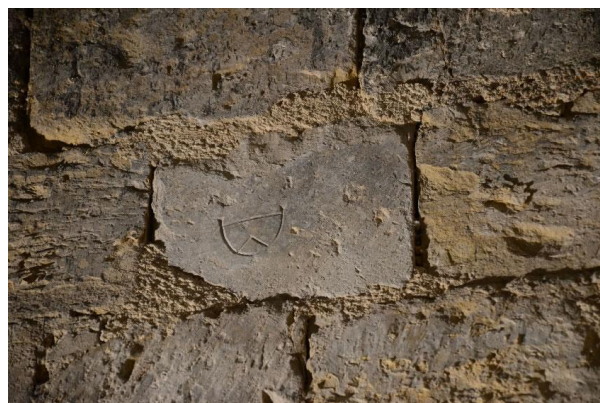
Castellane, chapelle Saint-Thyrse de Robion. Vue de détail d'un « D » sur un bloc remployé dans le parement intérieur du mur gouttereau sud de la nef (SDA 04)
