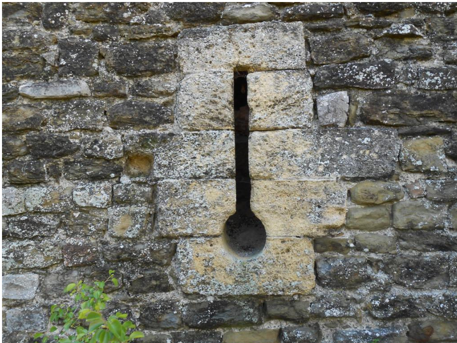
Meurtrière située sur le mur Nord du château
