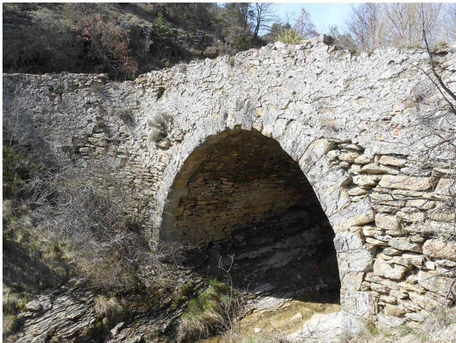
Pont sur la voie Royale (commune de Chateauneuf-Val-Saint-Donat)
