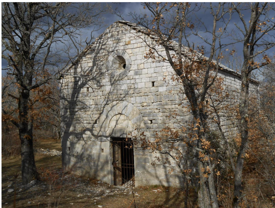
La chapelle après sa restauration
