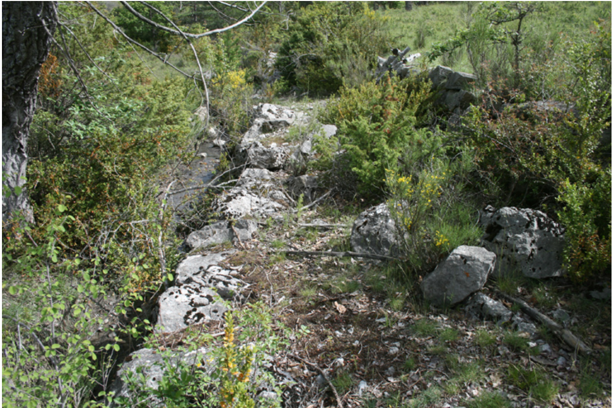
Lioux, voirie : chemin de Lioux à Serre Blanchard. Chemin muletier caladé entre le hameau de Lioux et Serre Blanchard.
