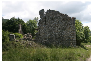
Lioux. Maison. Elévation est, mur monté en moellons calcaire. Phot. Maxence Mosseron IVR93_20080402079NUC1A
