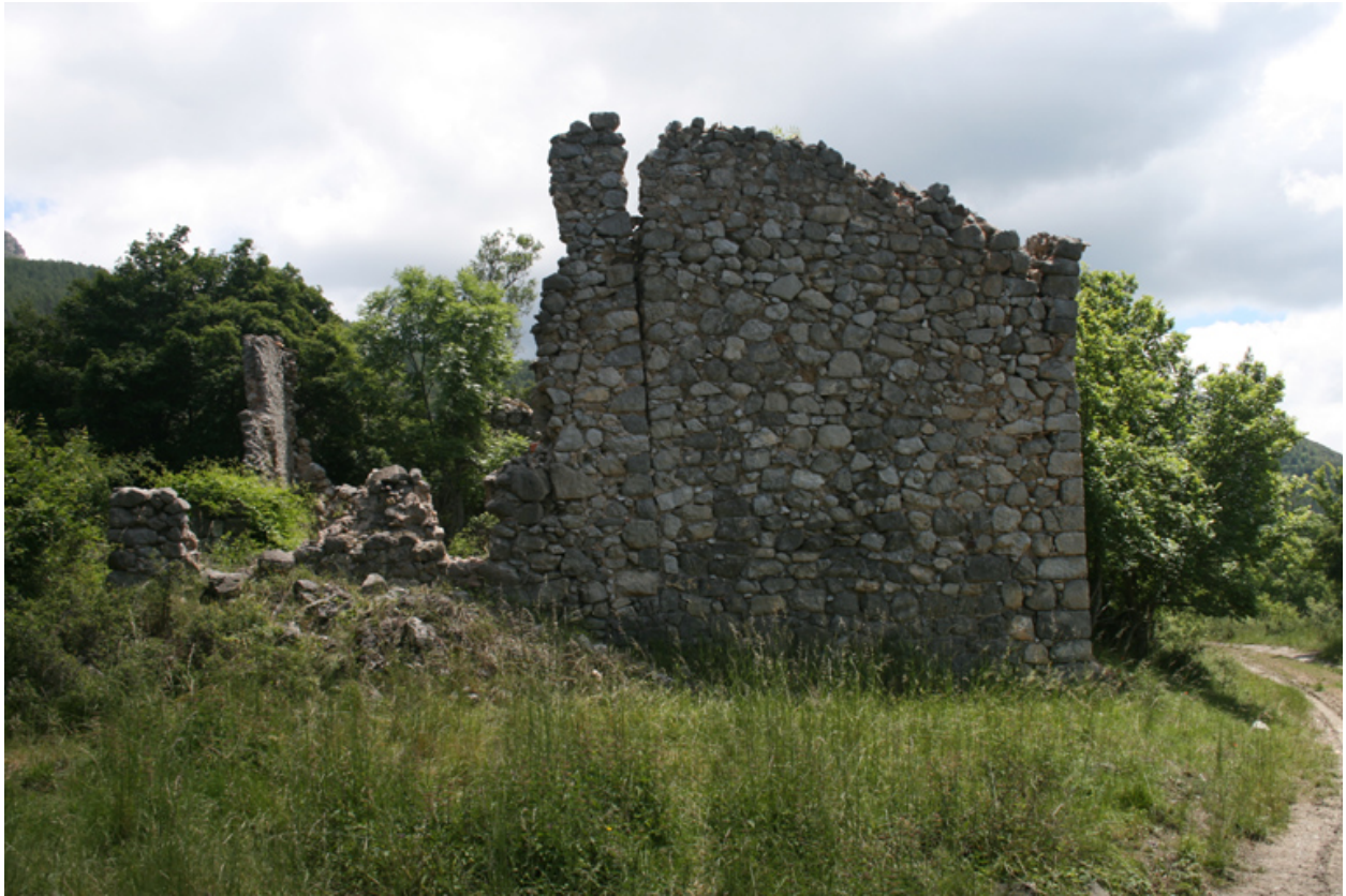
Lioux. Maison. Élévation est, mur monté en moellons calcaire.
