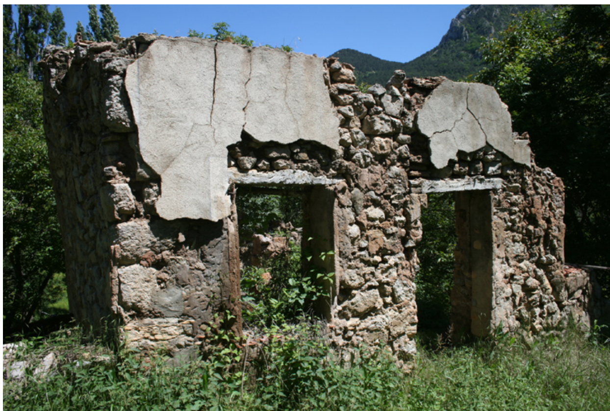
Boades (près de). Ferme. Revêtement de la maçonnerie au mortier de gypse.
