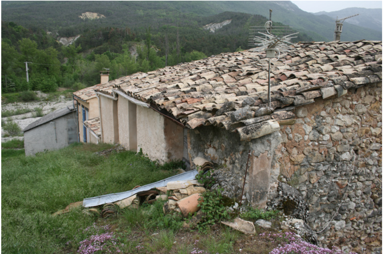
La Maurelière. Maisons. Vue des façades postérieures des maisons adossées à la colline, prise du nord.
