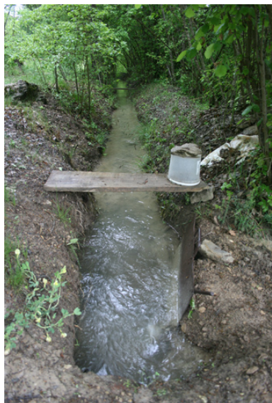
Le Village (près de). Canal d'irrigation. Canal d'irrigation de la Fraissie alimentant les terres cultivées des Feraïs. Phot. Maxence Mosseron IVR93_20080402077NUC1A
