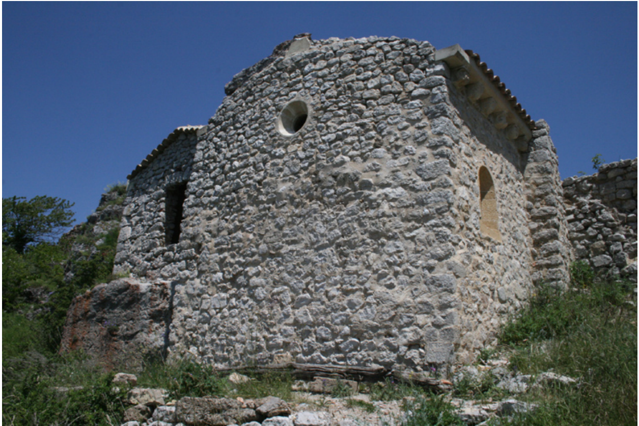
Le Poil. Eglise du Poil. Vue du massif occidental (chapelle).
