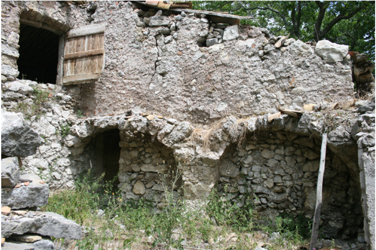
Les Moulières. Ferme. Voûtes en berceau segmentaire.
